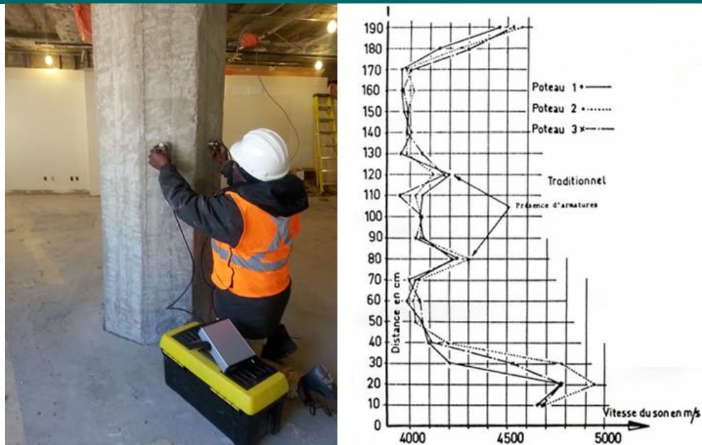
Figure 3 : Résultats d'essais soniques réalisés sur des colonnes
